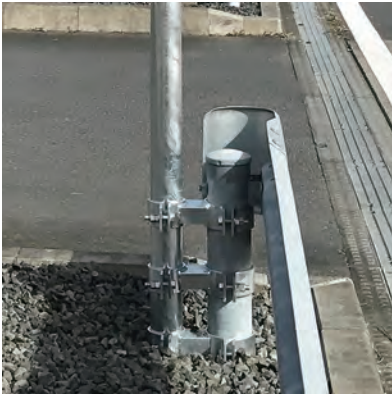
標準ピッチ:200mm ゆるみ止めナット
